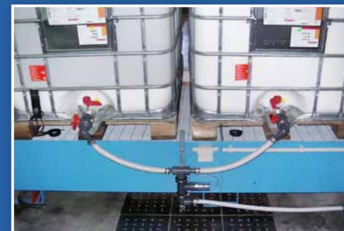
Doppelcontaineranschluß für unterbrechungsfreien Betrieb mit Sensor für Leermeldung (reagiert wenn Luft angesaugt wird) Connection of 2 IBCs for interruption free production with sensor for empty warning (reacts when air instead of adhesive is in the tube)
