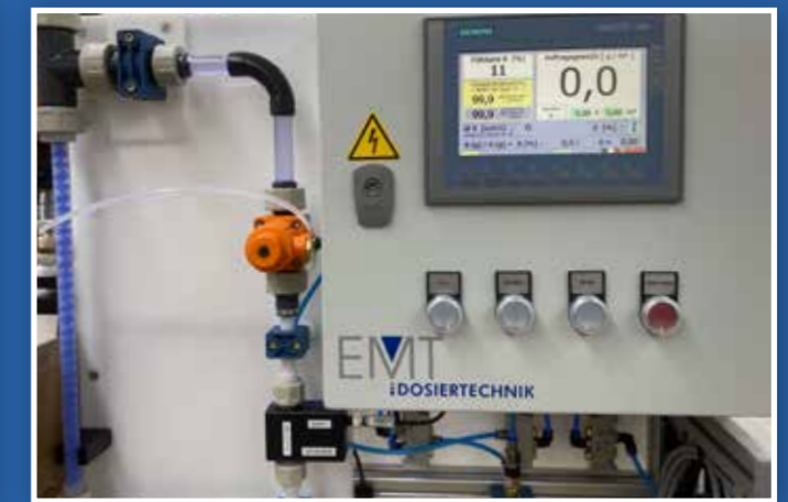
Touchscreen mit der optionalen Software für eine automatische Wasserspülung des Gemischbehälters und der Gemisch führenden Leitungen mit einer Abwasserpumpe Touchscreen with optional software for automated water rinsing of the mixed adhesive reservoir and hoses by a waste water pump
